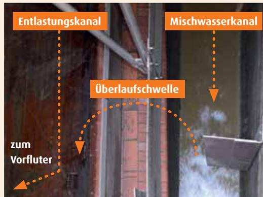
Die Überläufe im Wiesbadener Kanalnetz springen pro Jahr etwa 20 bis 30 Mal an und leiten dann für eine kurze Zeit stark verdünntes Mischwasser aus der Kanalisation in die Gewässer.
