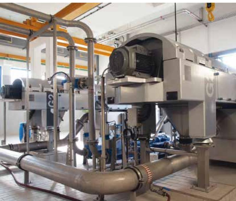
Besonders aufwendig ist die Vorbehandlung des Überschussschlammes aus der Rückspülung der biologisch aktivierten Filter. Da dieser Schlamm einen sehr hohen Wassergehalt aufweist, wird er zunächst in einem sogenannten Lamelleneindicker und in einer Zentrifuge weitgehend eingedickt. Aus den 5.600 m<sup>3</sup> Rückspülwasser, die täglich im Schnitt anfallen, werden auf diese Weise 25 m<sup>3</sup> Schlamm gewonnen und weiterverarbeitet.
