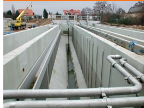
Sandfang im Bau
