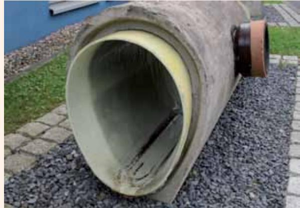
Kanalsanierung mit Inliner. Ein Inliner ist ein Schlauch aus Kunstharzmaterial, der die Haltung auf der Innenseite neu auskleidet. Er wird zunächst lose in die Haltung eingezogen und anschließend mit Druckluft aufgestellt, bis er eng an der Kanalwandung anliegt. Abschließend wird das Material durch UV-Bestrahlung ausgehärtet. Damit stellt der Inliner die neue Innenwand der Haltung dar. An Zuläufen erfolgen punktuelle Sanierungen durch Roboter.
