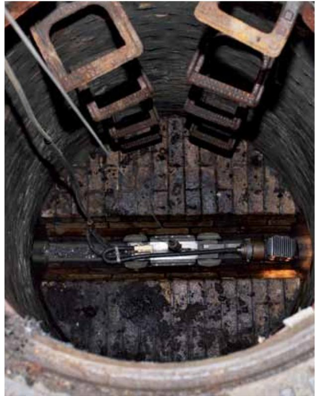
*Mit einer Seilwinde wird der Wagen durch einen Schacht in den Kanal gesetzt. Die Form der Räder ist an die Form des Gerinnes angepasst. Bei geringem Abfluss bleibt der Kamerawagen sogar trocken.*
