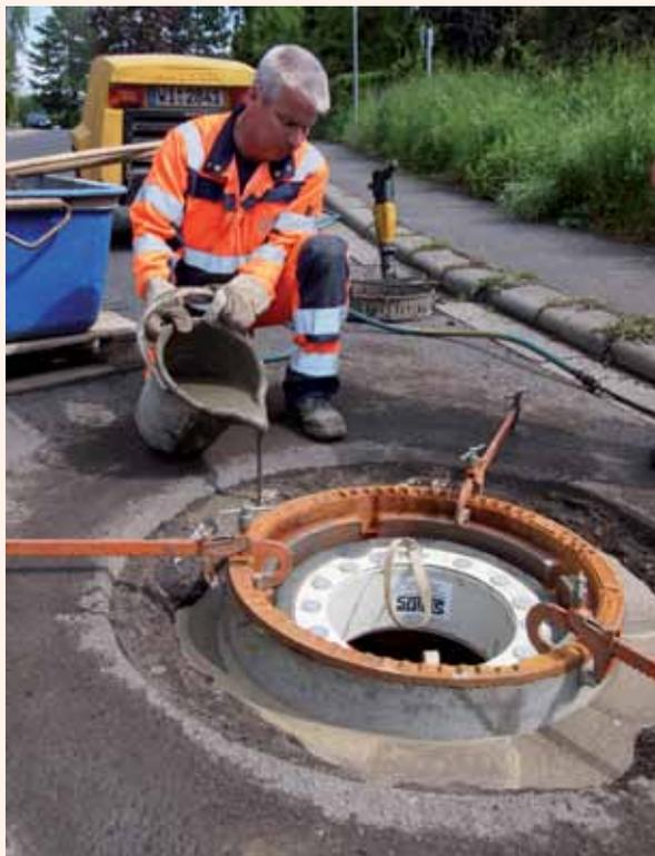
Schachtbauwerke, insbesondere der Schachtrahmen, in dem der Schachtdeckel liegt, können durch die permanente Verkehrsbelastung beschädigt werden. Dann wird von ELW-Spezialisten die Straßendecke kreisförmig aufgesägt, der Schachtrahmen wird freigelegt und ausgetauscht. Dank spezieller schnellbindender Baustoffe ist die Baumaßnahme schon nach 2 bis 3 Stunden vollständig abgeschlossen und die Straße wieder befahrbar.
