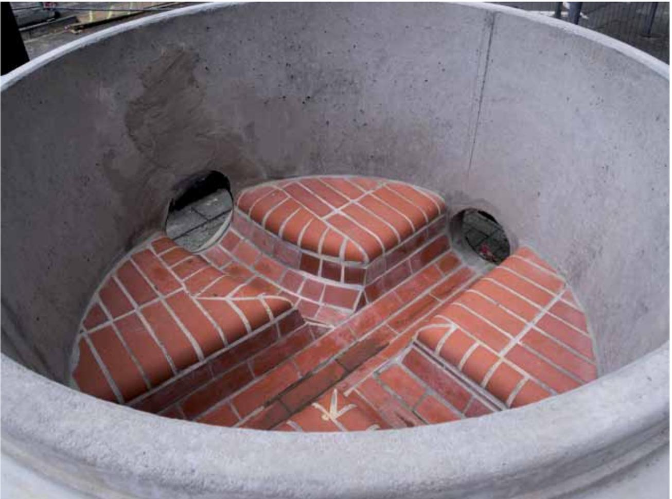
*Spezielle Kanalbauteile wie Kurvenstücke oder Einmündungen werden als sogenanntes Bauwerk vorbereitet und bei offener Bauweise fertig in die Baugrube eingesetzt. Auch das hält die Bauzeit kurz. Der wasserführende Teil dieser Bauwerke besteht meist nicht aus Beton, sondern ist aus den widerstandsfähigeren Kanalklinkern gemauert.*
