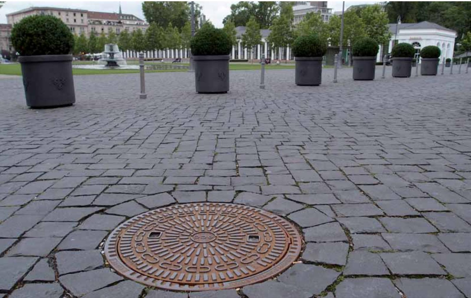
*Ein alltäglicher Anblick: der Kanaldeckel, Fachbegriff: Schachtabdeckung. Etwa 18.500 Schächte gehören zur Wiesbadener Kanalisation. Sie be- und entlüften den Kanal und bieten Zugang für die regelmäßige Inspektion und Reinigung. Den Kanalabschnitt zwischen zwei Schachtbauwerken nennt der Fachmann Haltung. Im Winter kann Nebel aus den Schächten steigen, wenn das warme Abwasser viel Wasserdampf abgibt.*
