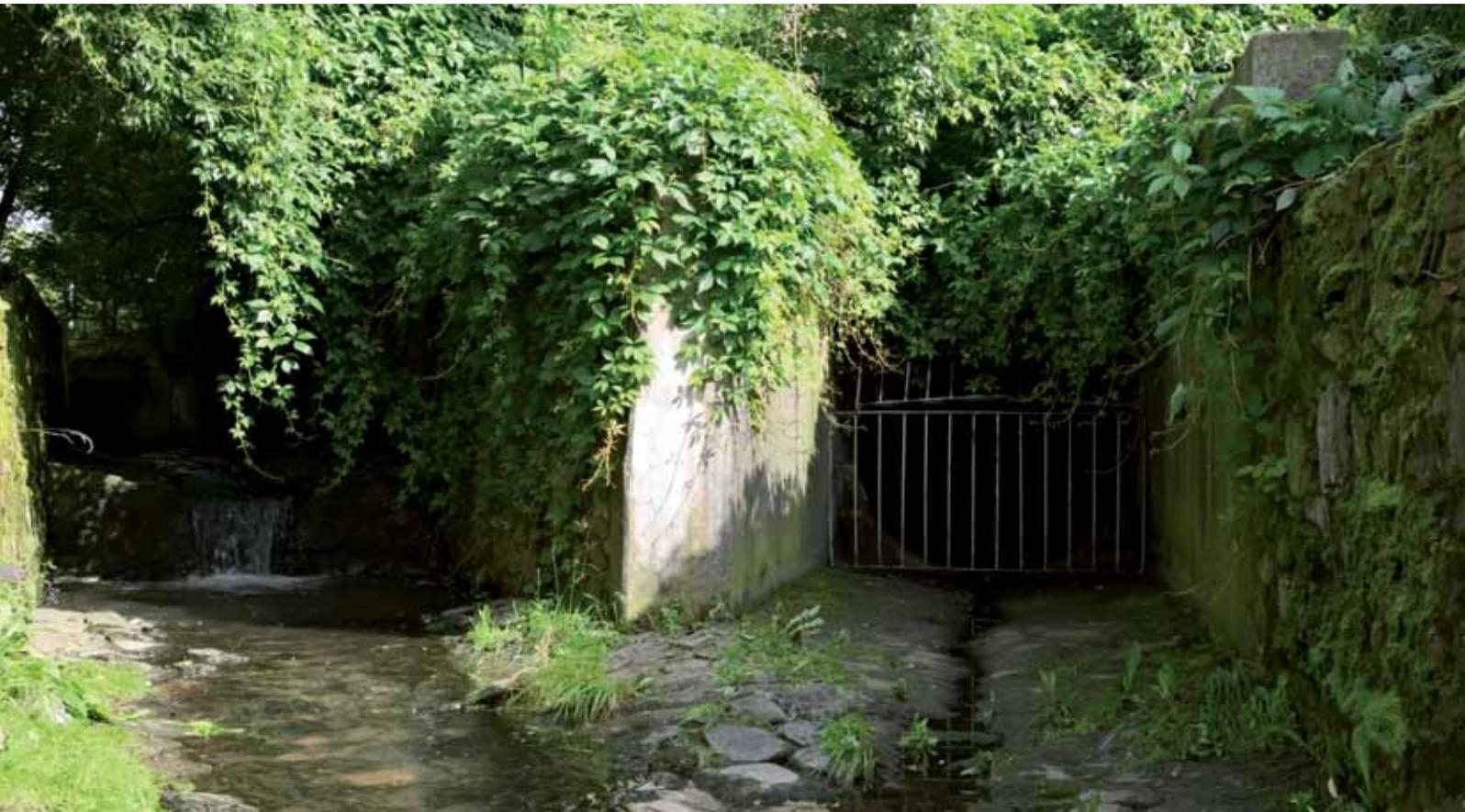
*Der Auslass eines Regenüberlaufes in Biebrich. Da es lebensgefährlich wäre, die Kanalisation ohne Sicherheitsmaßnahmen zu betreten, sind die Auslässe vergittert.*
