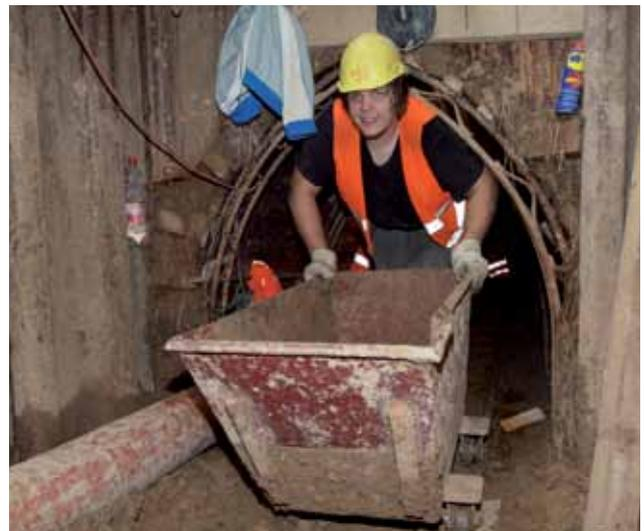
*Zugang einer Baustelle in bergmännischer Bauweise. Bei offener Bauweise müsste die Straße vollständig gesperrt werden.*
