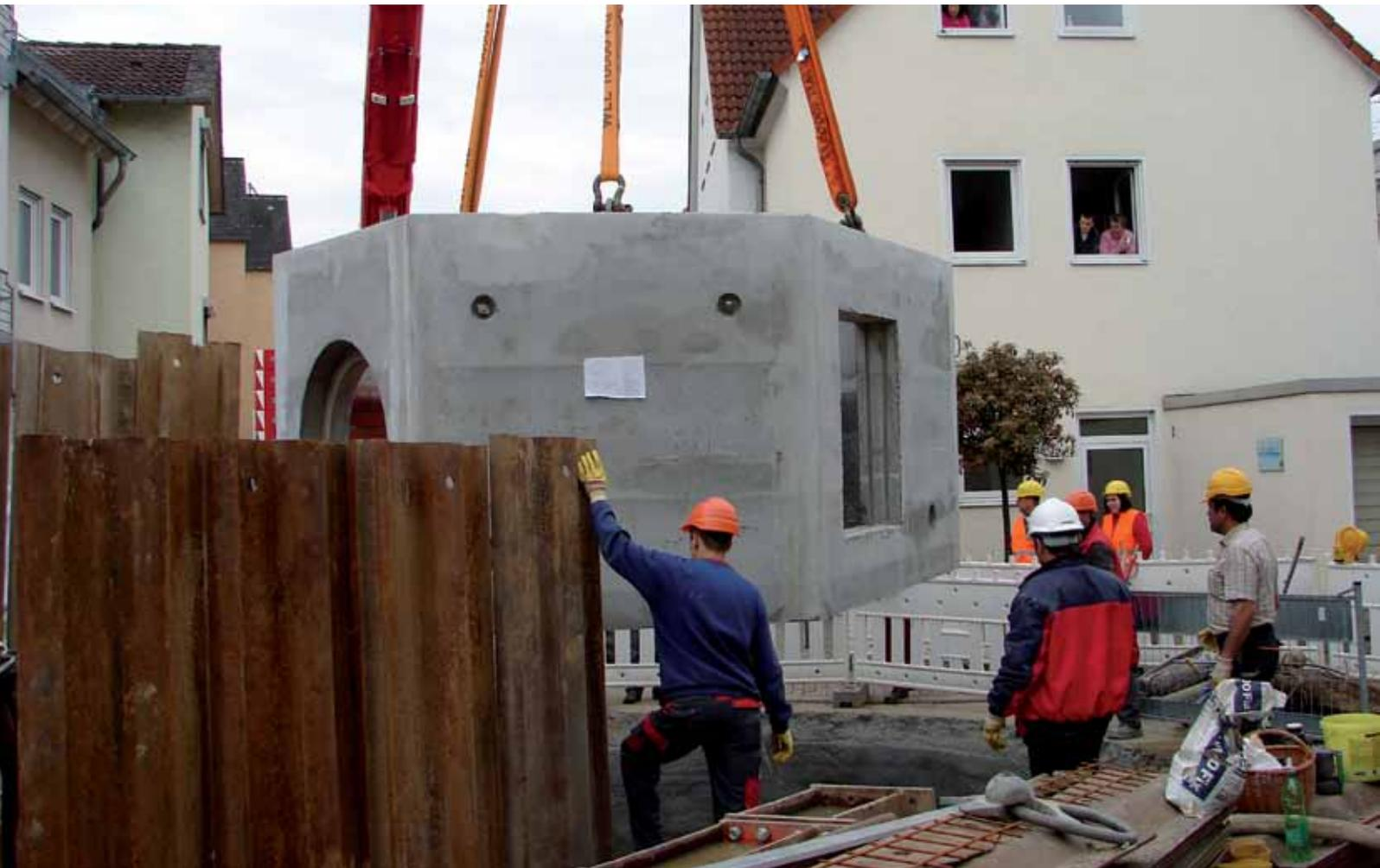
*Ein fertiges Bauwerk aus Beton mit einer gemauerten Kanaleinmündung wird mit einem Kran in die Baugrube eingesetzt. Die Kanalanschlüsse sind schon entsprechend vorbereitet.*
