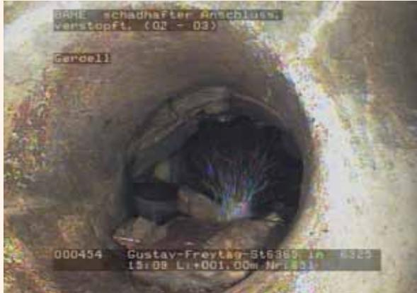
Hier wurde bei der TV-Untersuchung ein Schaden festgestellt. Die anschließende Auswertung kommt zu dem Ergebnis, dass sofortige Maßnahmen erforderlich sind, um größere Folgeschäden zu vermeiden.
