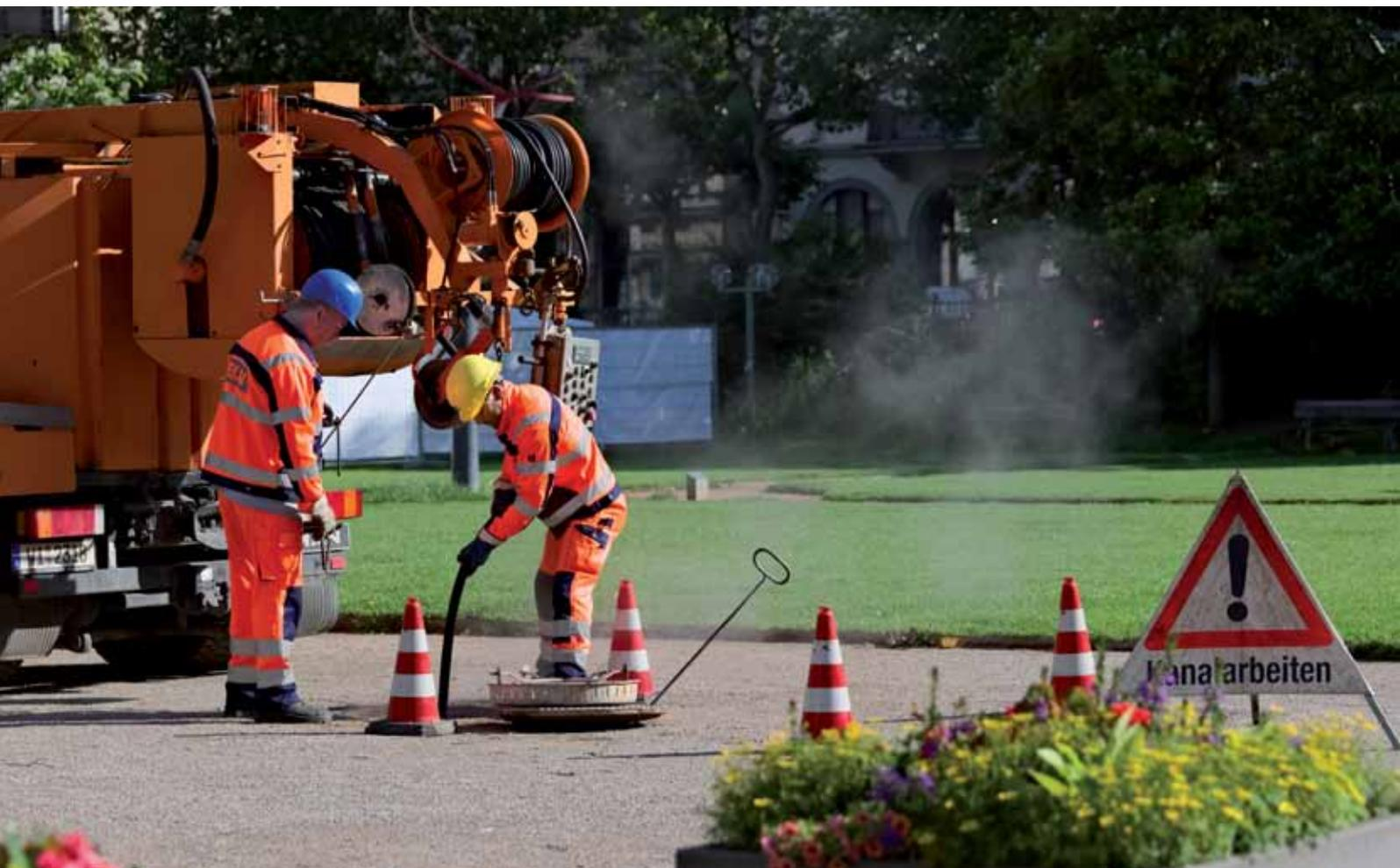
Um die einwandfreie Funktion der Kanäle zu gewährleisten, werden sie von den Mitarbeiterinnen und Mitarbeitern des Kanalbetriebes regelmäßig gereinigt und überprüft. Der Reinigungsbedarf fällt dabei sehr unterschiedlich aus: Kanäle mit hohem Gefälle lagern kaum Schmutz ab, da der starke Abwasserstrom auch gröbere Stoffe gut mit sich nehmen kann. Hier kann ein drei- bis vierjähriger Reinigungszyklus genügen. Kanäle mit weniger Gefälle dagegen müssen mehrmals im Jahr gereinigt werden.
