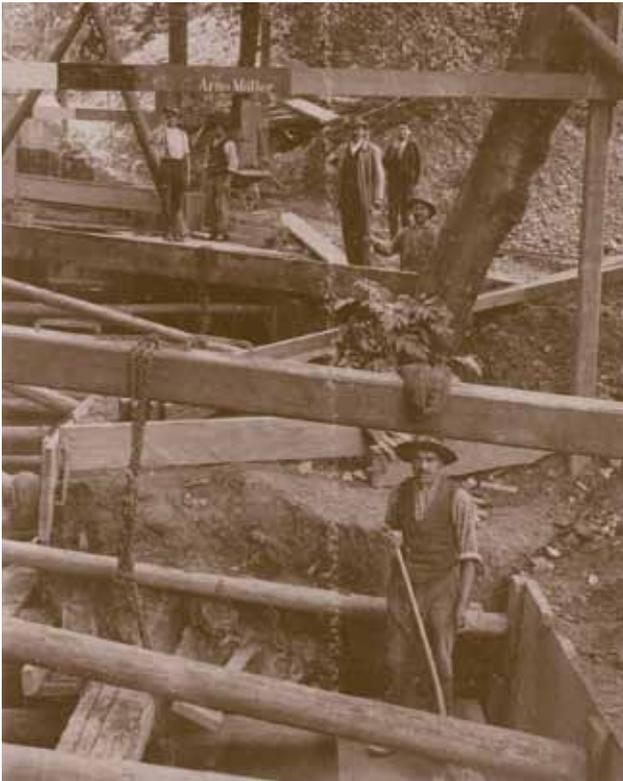
Der Salzbachkanal, 4,5 Meter hoch und 5 Meter breit, verläuft 7 Meter unterhalb der Wilhelmstraße. Er wurde vollständig von Hand aus eigens gebrannten Klinkern mit Spezialmörtel mehrlagig gemauert. Bach- und Mischwasser werden hier separat geführt. Als eindrucksvolles Beispiel früher Ingenieurskunst steht das Bauwerk unter Denkmalschutz und kann an bestimmten Tagen besichtigt werden.
