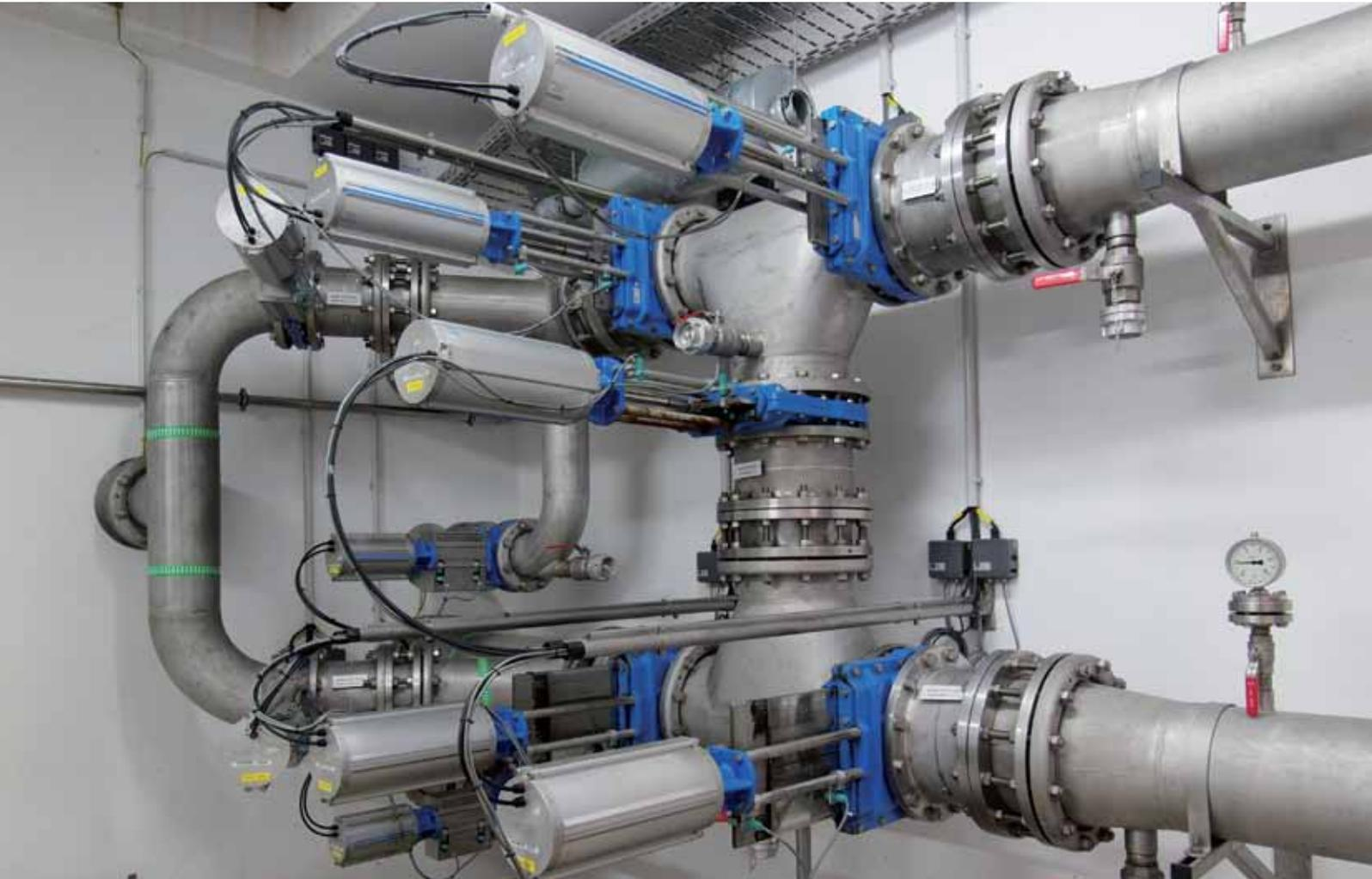
*Mit so einer elektrisch gesteuerten Schieberkreuzung lässt sich die Förderleistung mehrerer Pumpen bedarfsgerecht auf die Druckleitungen (rechts) verteilen.*
