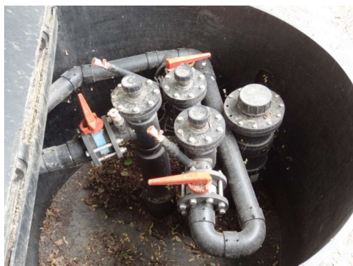
Abbildung 25: Gasbrunnen 3.11 mit drei Entgasungsrohren und einem Sickerwasserförderrohr (DA I)
